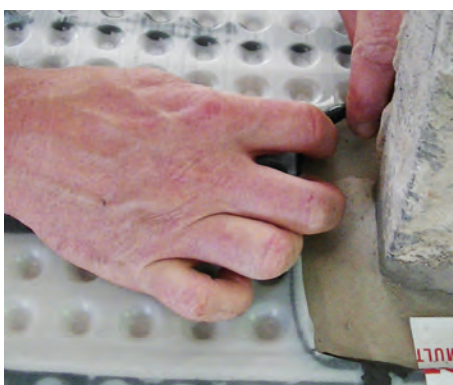
26. Montera ihop zoner/rum genom att applicera fogband längs kanten av skarvdelen på båda sidor av öppningen. Viktigt att det blir tätt mellan respektive Fogband i respektive zon/rum.
