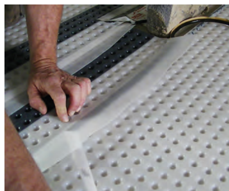
24. Applicera Skarvbandet, dra bort skydds-folien och tryckfast passbitens överlapp. Se till att den bortre skarven ligger kant i kant.
