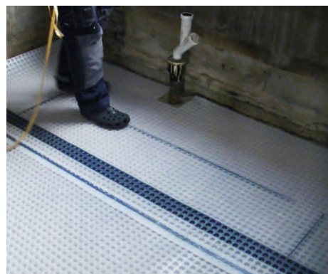
21. Tryck till Fogbandet mot golvet runt hela kanalen.
