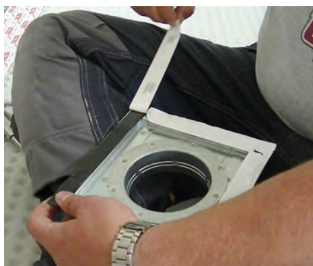
32. Applicera Skarvband på undersidans kant på Luftstoslådan runt om.
