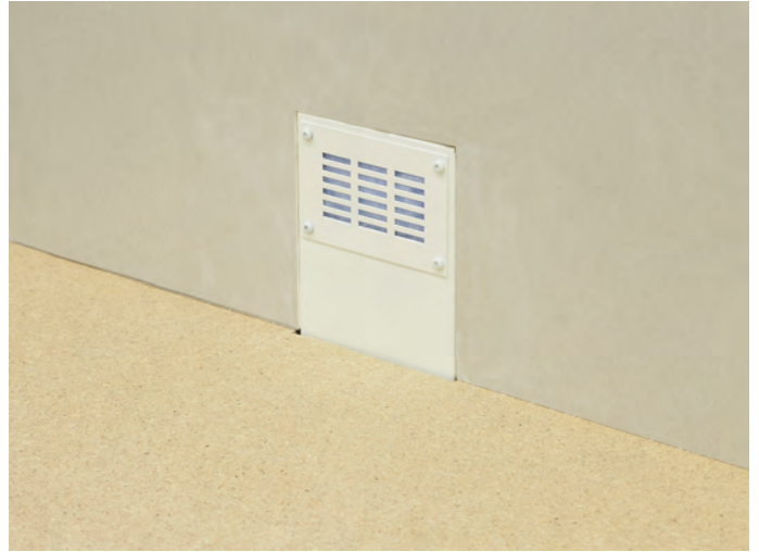
Golvspån installerad. Här är Vägdonet infällt i en gipsskiva.
