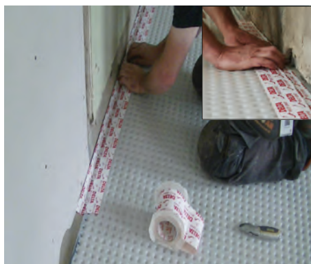
29. Applicera DELTA*-MULTIBAND runt om White Line fuktskyddsmattan. OBS! Vik ner tejpen längs kanten utan att trycka ner mattkanten.
