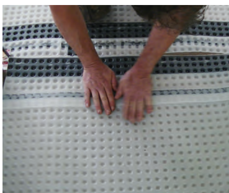
25. Tryck fast över Skarvbandet och stryk sedan med handen över tills du ser att hela skarvbandet är i kontakt med White Line fuktskyddsmatta.
