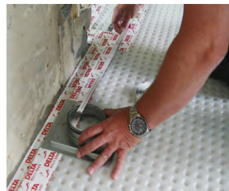
30. Mät ut vart sugpunkten skall vara enligt ritningen. Markera på White Line fuktskyddsmattan.
