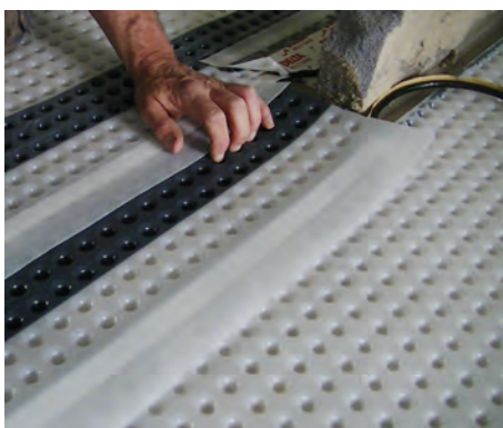
23. Montera ihop olika zoner/rum genom att skära till en passbit av White Line fuktskyddsmatta med ett överlapp (mattans släta del).
