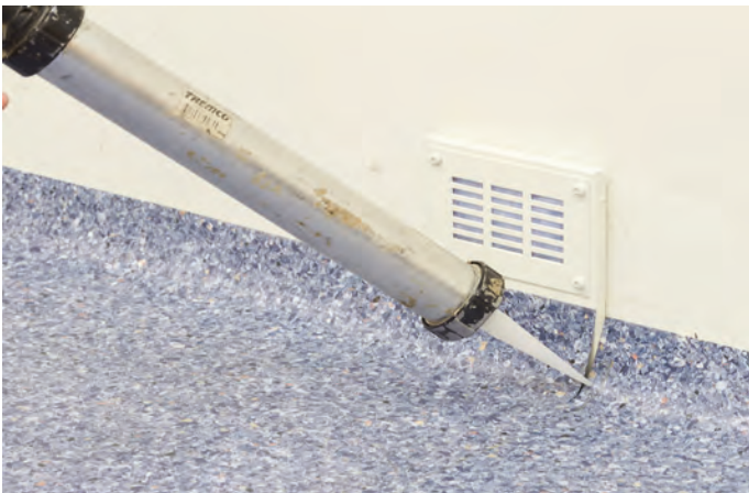
Täta kanten mellan plastmatta och Vägdon med en mjukfog.
