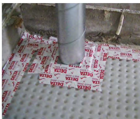
35. Montera ventilationsröret på sugpunkten.
