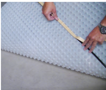
20. Applicera Fogbandet mellan distansraderna "kopparna" på undersidan. Dra bort skydd-folien från Fogbandet och lägg ner White Line fuktspärmmattan.
