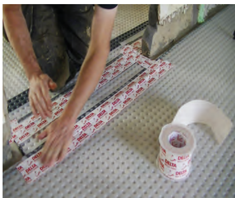
28. Applicera DELTA*-MULTIBAND runt om.
